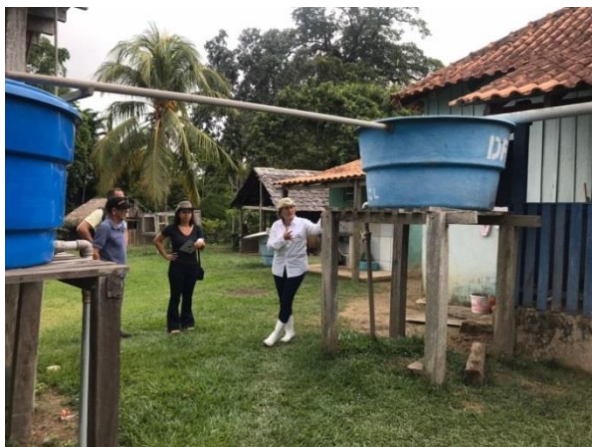
Caixas d`agua para armazenamento de água da chuva que será transportado até os potes.
